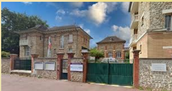
Saint-Germain, bâtiment de la Loge
